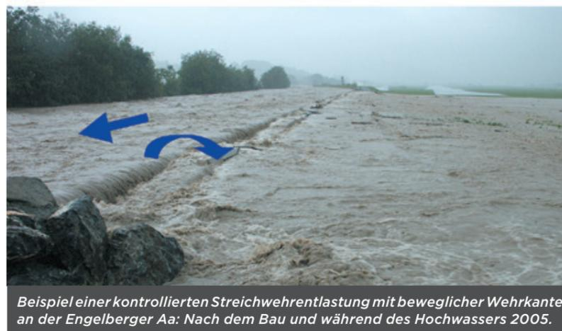
Beispiel einer kontrollierten Streichwehrentlastung mit beweglicher Wehrkante an der Engelberger Aa: Nach dem Bau und während des Hochwassers 2005.
